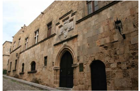
Fachada de la “Lengua” de Francia. Calle de los Caballeros. Rodas.
